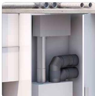
Die **Leitungsführung für die Abluft** wird mittels der in die Betondecke eingelegten FRS-Rundrohre realisiert. Alle Lüftungsleitungen verschwinden somit unsichtbar in der Baukonstruktion. Einzig das Lüftungsgerät und die Verteilerkästen erhalten einen Revisionszugang für eine einfache Wartung.
